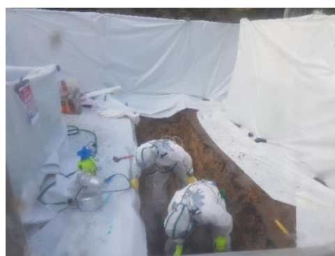
Boissy Sous-Saint-Yon Dépose de canalisation fibrociment
