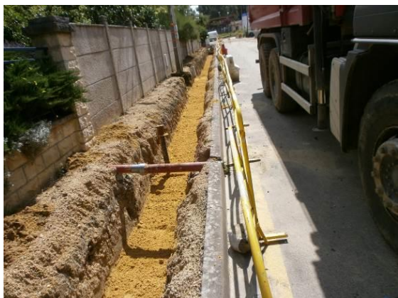
Tranchée technique enfouissement de réseaux
