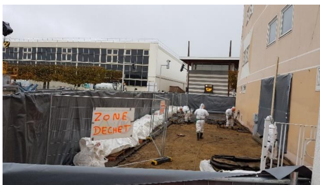
Paray-Vieille-Poste Décroulage d'enrobé amianté
